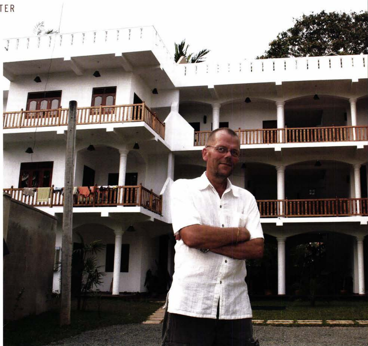
FULGTE DRØMMENE: Helge Källman har bygd opp Nor Lanka Hotel fra grunnen på Sri Lanka. Hotellet har ni dobbeltrom med dusj og kaldt og varmt vann, og er på til sammen cirka 900 kvadratmeter i tre etasjer.
