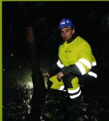
INGEN SKJELETTET: Det var tyskerne som under krigen bygget ut Jærbanen til normal sporvidde, forteller byggeleder Morten Wangen,
