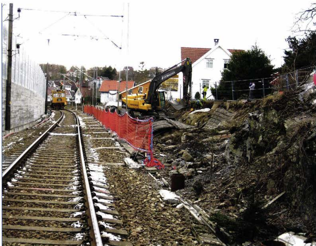
TETT PÅ: Det er krevende å drive omfattende sprengning tett på inn på villa-bebyggelsen og eksisterende spor.
