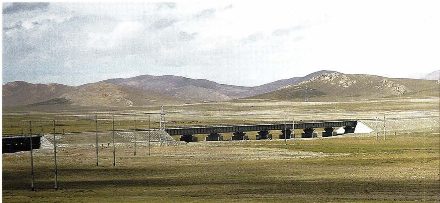
SLYNGER: For å hindre at permafrosten tiner er store deler av banen bygd på bruer. Banen slynger seg gjennom det tibetanske høylandet.
