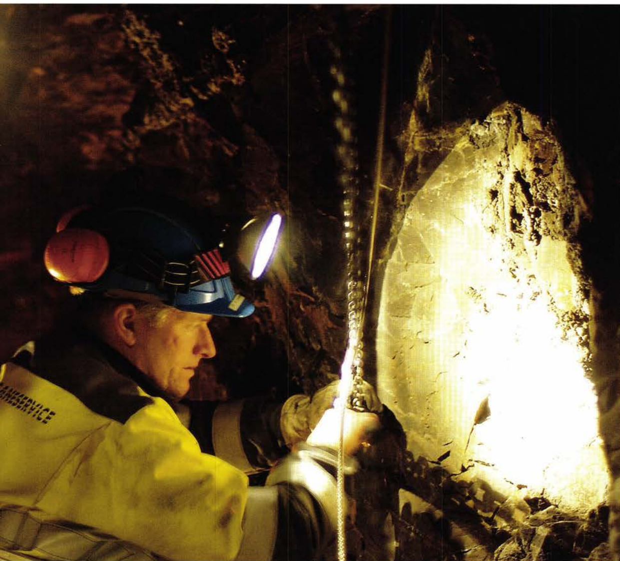
BYGGHERRENS HALVTIME: En kontrollingeniør vil heretter registrere og undersøke fjellet for hver femte meter. (Bildet er tatt i en annen sammenheng).
