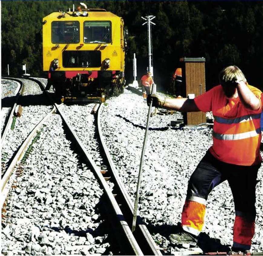
MYKJE Å GJERE: Per Bekken i Baneservice tørkar sveitten. Det kan bli enda meir å gjere når omsetninga i selskapet skal doblast innan 2010.
