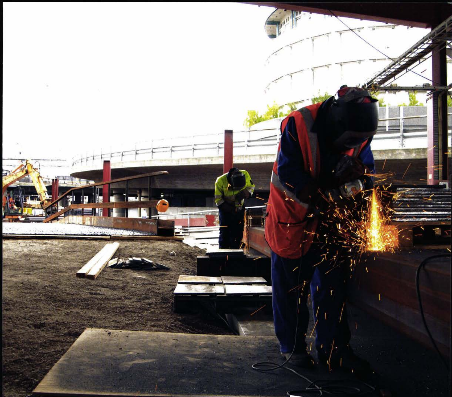
I GANG: Byggingen av Citybanan er i gang og har allerede kostet en milliard kroner. Her bygges en arbeidstunnel for en ny underjordisk stasjon i bykjernen av Stockholm.
