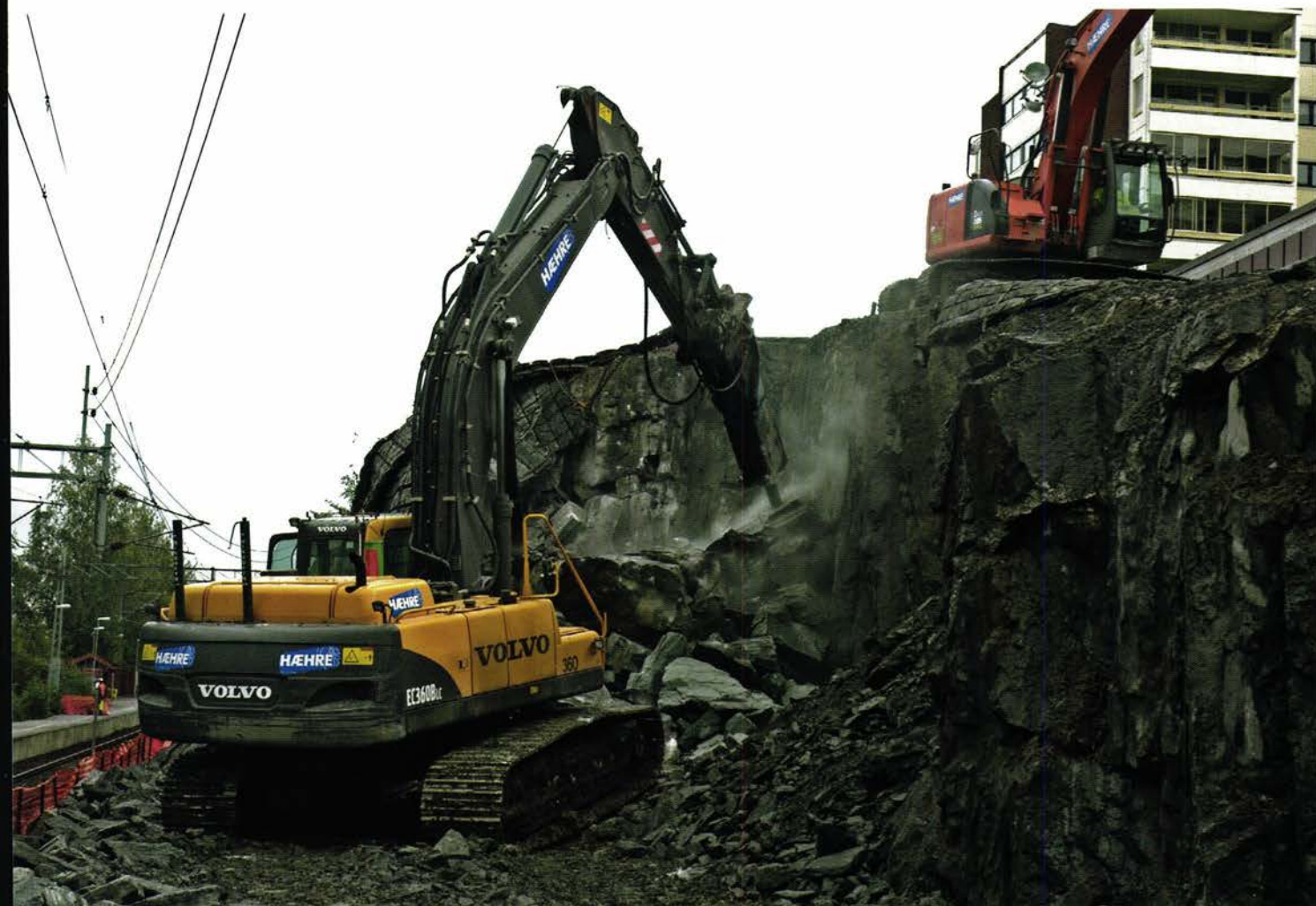
BYGGES OM: Mange stasjoner bygges om, blant andre Haugenstua i Oslo.
