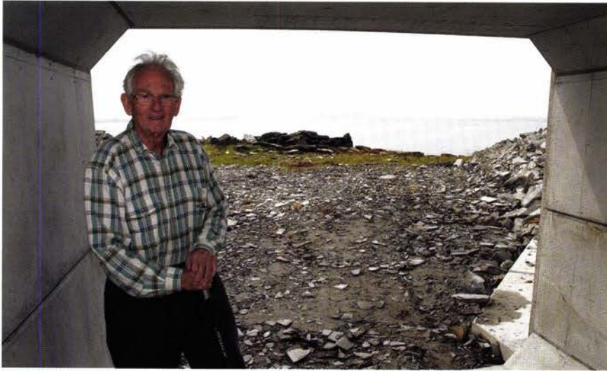
GLAD: Egil Johnson gleder seg over at Jernbaneverket har bygd kulvert ved Saltens flotteste og varmeste badeplass.
