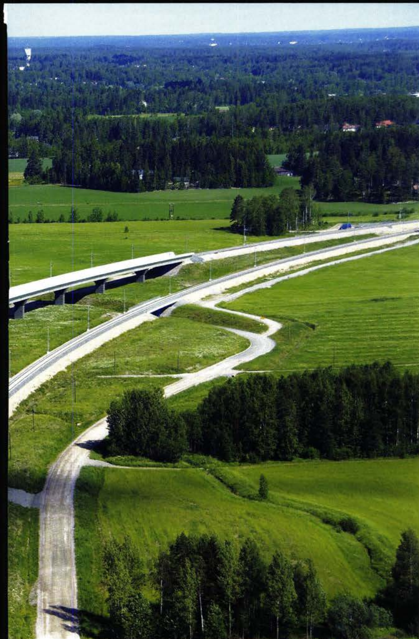
NY BANE: Finnene har bygd en helt ny jernbane på 63 kilometer mellom Kervo og Lahtis nord for Helsinki.
