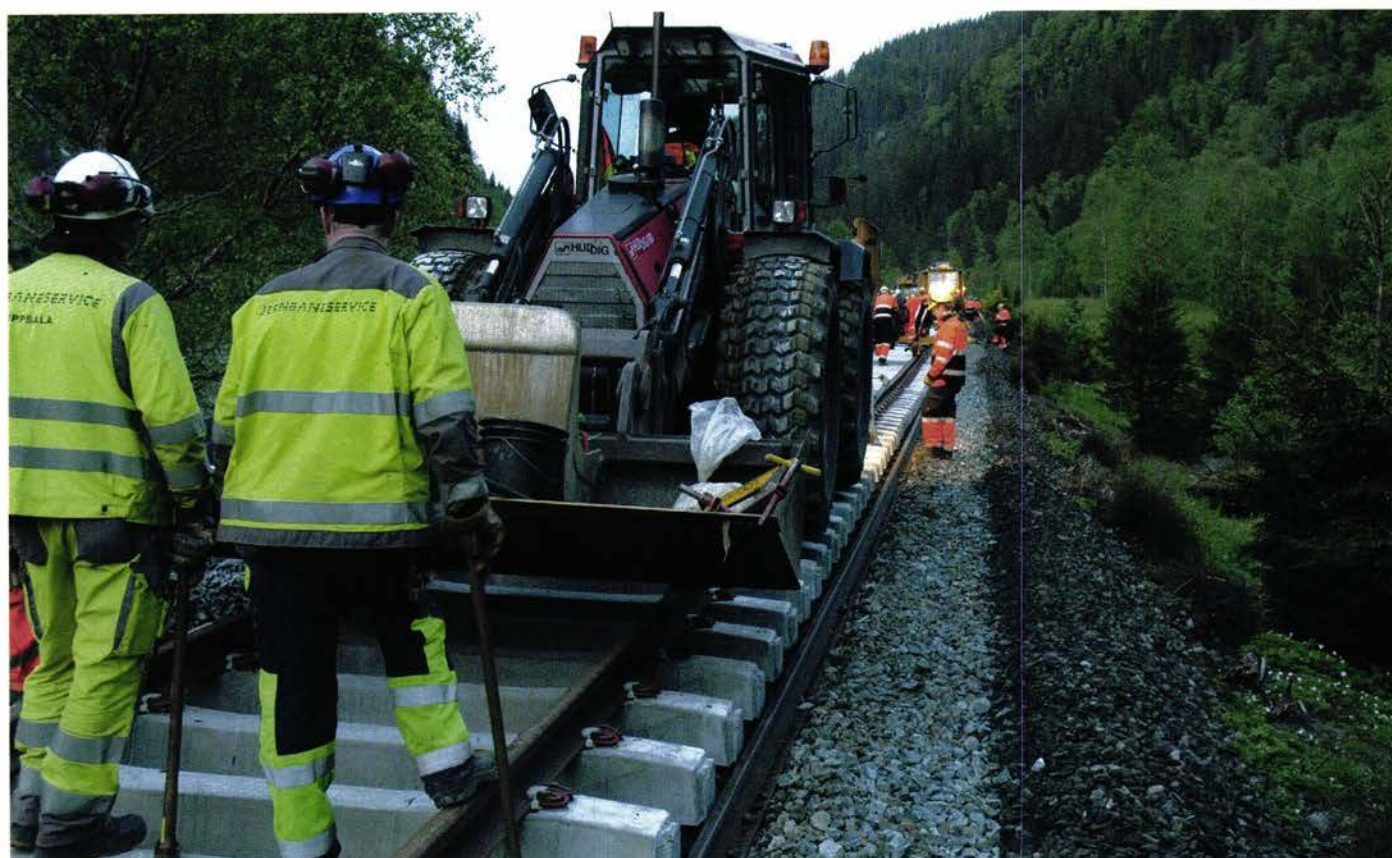
FESTER SKINNENE: Bak sporombyggingstoget kommer en maskin som fester skinnene til svillene med såkalte Pandrol-fjærer.
