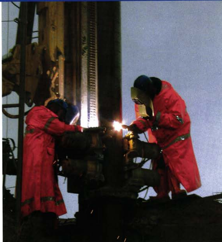
BORING: Stangeland Maskin er entreprenør på parsellen Jåttåvågen. Bildet viser boring for bjelkestengsler i Jåttåvågen.
