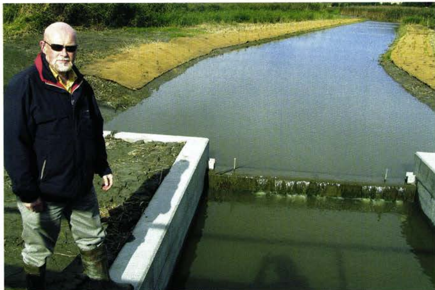
KANAL: – Elva er omdannet til en snorrett kanal, og fisken er allerede observert, forteller prosjektleder Knut Brattvang i Jernbaneverket Utbygging.
