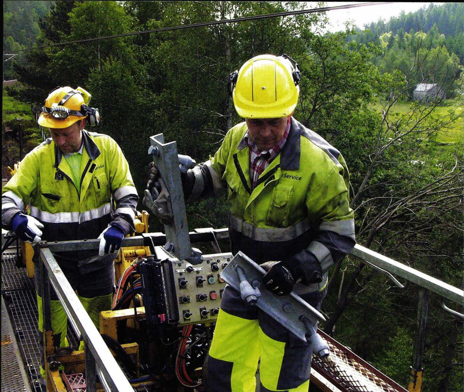
Perje Tangen er i gang med å montere utliggerkonsoller.
