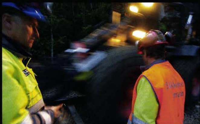
NATTSKIFT: Det er bektisk på nattskift. I løpet av tre timer, mellom siste natt-tog og første morgentog, skal oppdraget utføres.
