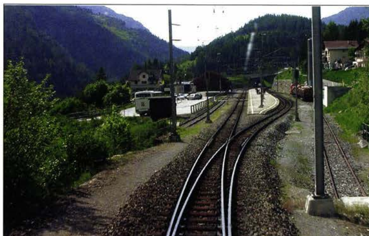
Kryssingspor: Kryssingssporene ligger ved jevne mellomrom, og flere av dem er også forlenget.
