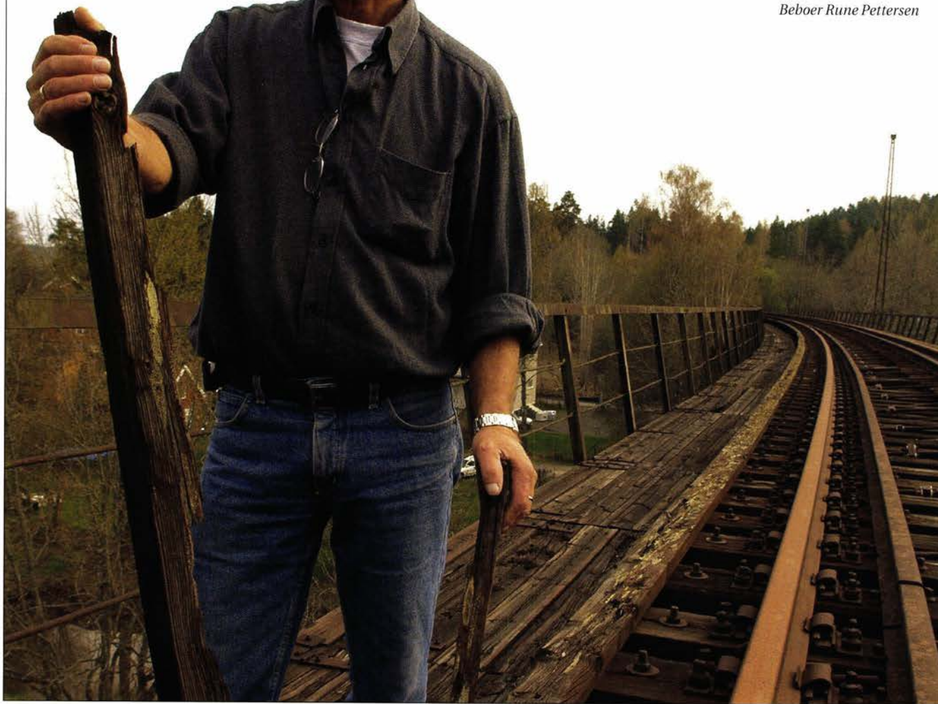
Råtner: Jernbanebrua råtner og rustet. – Heldigvis har det ennå ikke skjedd en ulykke her, sier Rune Pettersen.
