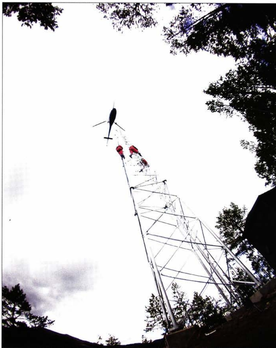
Fortsetter. Utbyggingen av togradionettet fortsetter på Gjøvikbanen, Østfoldbanens østre linje og Flåmsbanen.
