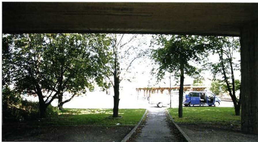
Mitt og ditt: Plenen til høyre er med i kontrakten, den til venstre tilhører vegvesenet, tror gutta, som har klippet begge. (Foto: Per Rathe).
