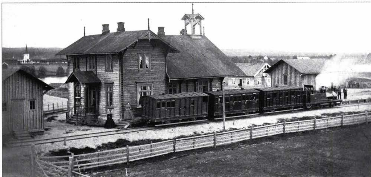
Ingen jernbaneulykke: Historieprofessor Trond Berg mener at byggingen av en rekke smalsporede baner ikke var noen ulykke for Norge, tvert om. Her fra Elverum stasjon i om lag 1865. (Foto: NJM)
