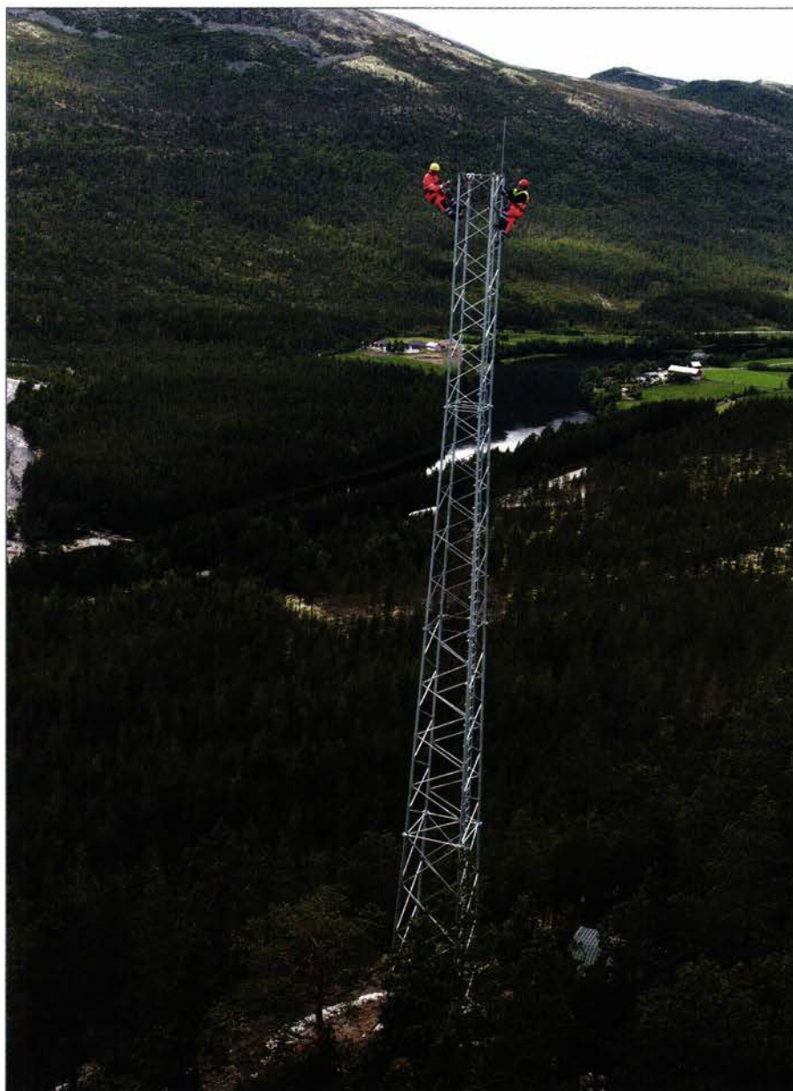
Montering: Fra mastemontering på Øykletten, Rørosbanen sør for Alvdal i juni i år. (Foto: Øystein Grue).
