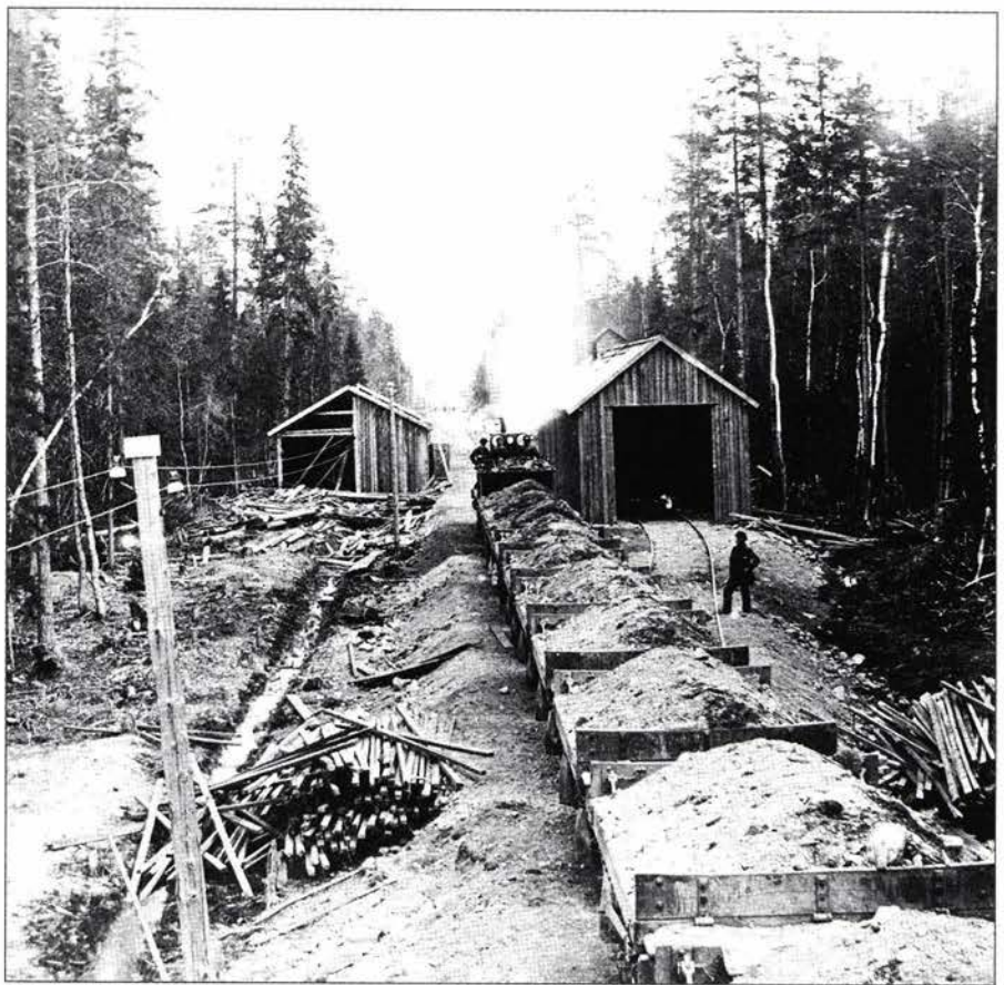
Mot alle odds: Stikk i strid med dystre spådommer fortsatte utbyggingen av jernbanen kort tid etter at Norges første jernbane ble åpnet. Her hentes grus til byggingen av Kongsvingerbanen i 1862. (Foto: NJM)
