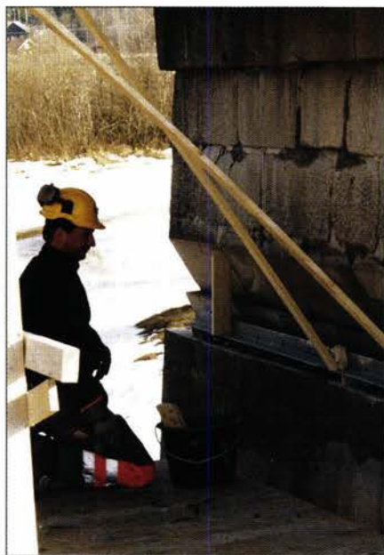
Slisse: Slissa er sagt ut i det gamle bruelementet og et stålprofil støpes fast ved Kongsvingerbanen.
