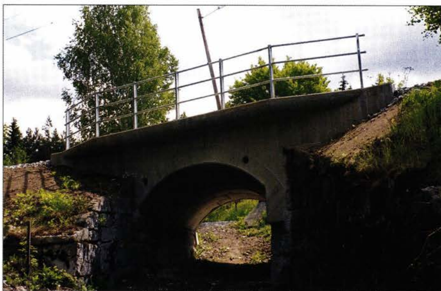
Etter: Dette bildet viser den nye betongbrua over den samme turvegen ved Kongsvingerbanen.
