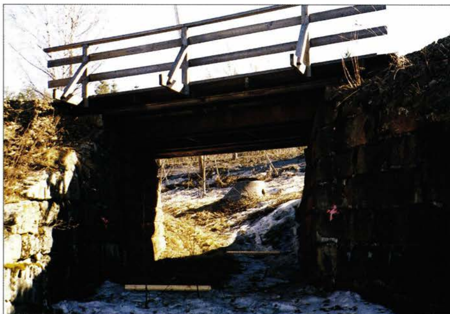
Før: Dette bildet viser den gamle stålbejelkebru over en turveg ved Kongsvingerbanen.
