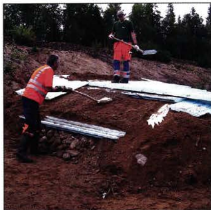
Isolerer: Lars-Olov Lundberg, Skanska, og Jonas Rådman, TK Spår, legger isolering over ormenes nye overvintringsplass.
