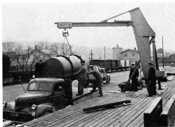
3 tonns svingkran i arbeid på Lillestrøm st.
