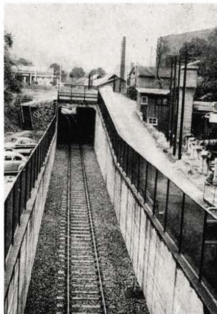
Fig. 15. Sporet sett fra Bru 5 mot Bispegaten. På høyre side atkomstvei til Sentralfyrrhuset.
