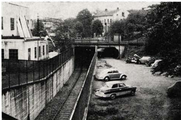
Fig. 14. Sporet sett fra Bispegaten mot Bru 5. Til venstre Sentralfyrrhuset.
