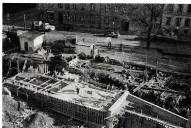
Fig. 7. Søndre ende av lukket ramme under Bispegaten, ferdigstøpt. 11. oktober 1954.
