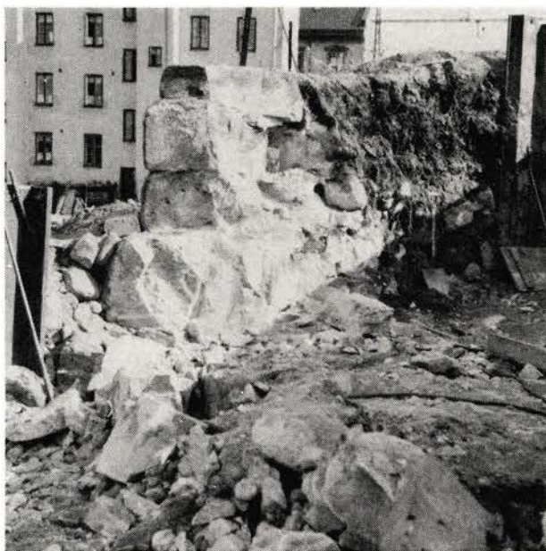
Fig. 10. Gammel «injisert» mur på nordsiden av Hovedbanens gamle fylling.
