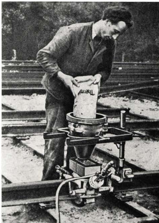
Fig. 5. Digenen fylles med sveisemasse.
