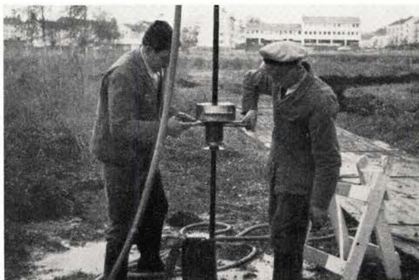
Fig. 2. Nedpressing av boret med belastning.
