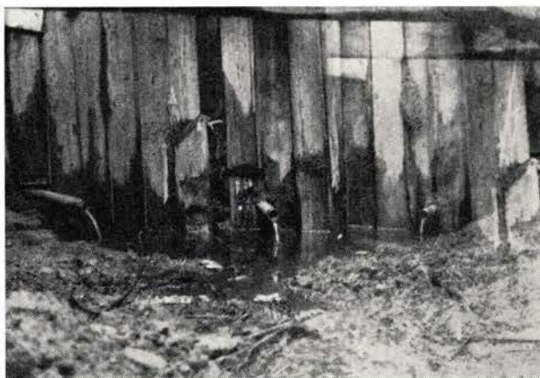
Fig. 9. Foto av vannføring i filterrør \varnothing = 1\frac{1}{2} " like etter innramming.
