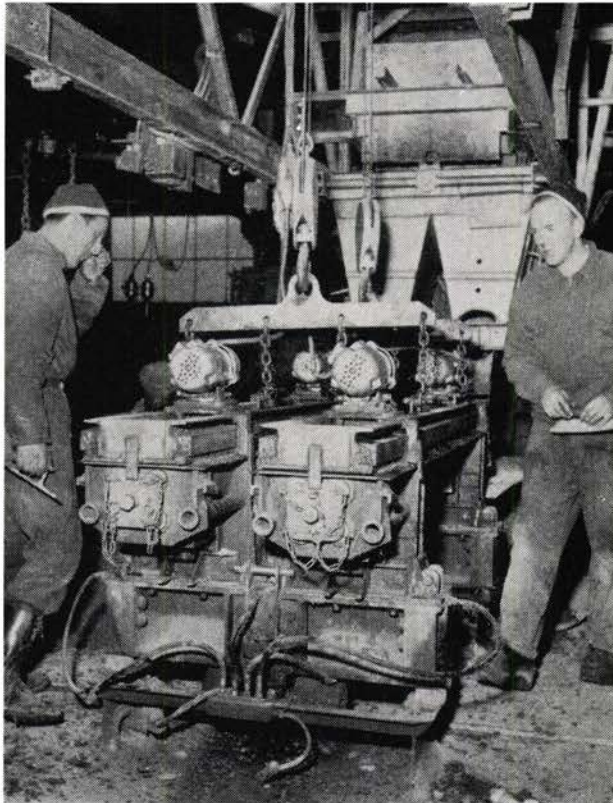
Fig. 5. Støping av spennbetongsviller. Vibratoren er senket ned på de fylte former.
