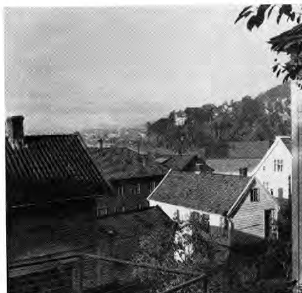
Fig. 5. Utsikt fra tunnelinnslaget i Fløen, mot Bergen st.
