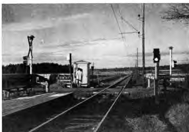
Fig. 5. Enkeltstående planovergangssignaler ved automatisk vegbomanlegg.
