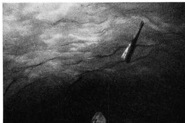
Fig. 19. Påsprøytet tak.
