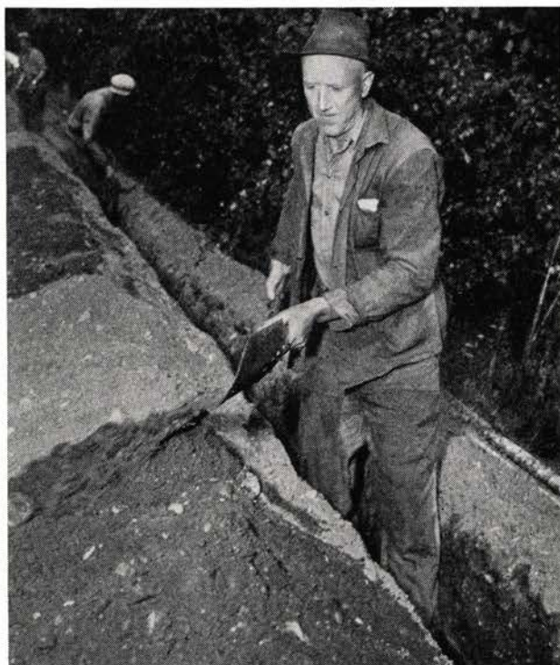
Håndgraving av kabelgrøft.
