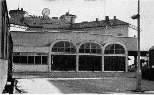
Fig. 9. Plattformsiden. Til venstre vindu til venterom.
