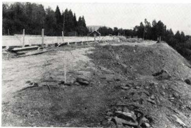
Fig. 8. Vakås 1954. Fyllmassen var stein og sank ned i den underliggende leiren. Foto i ytre spors retning.
