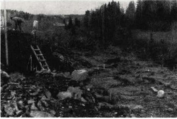
Fig. 13. Vakås 1954. Kontrafylling av stein utlegges. Poretrykksmåling i den underliggende leire.
