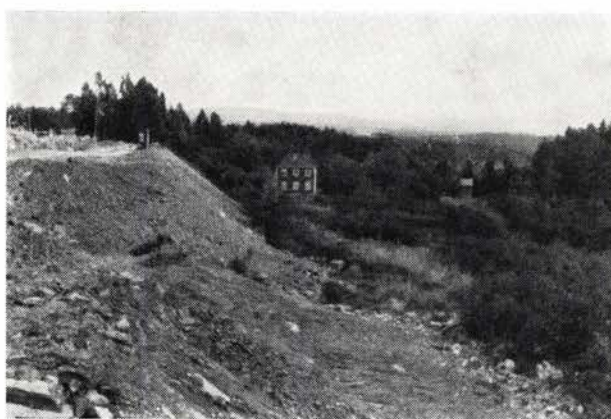
Fig. 9. Vakås 1954. Utsikt nedover bekkedalen på skrå av linjereiningen.
