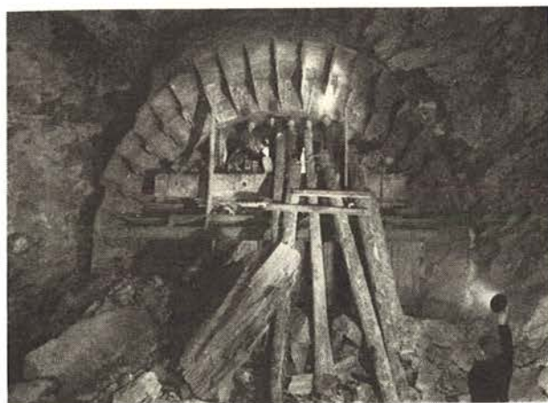
Fig. 7. Gjennombrudd til fjelltunnelen. Tømmerstokkene satt opp for sikring mot steinras.
