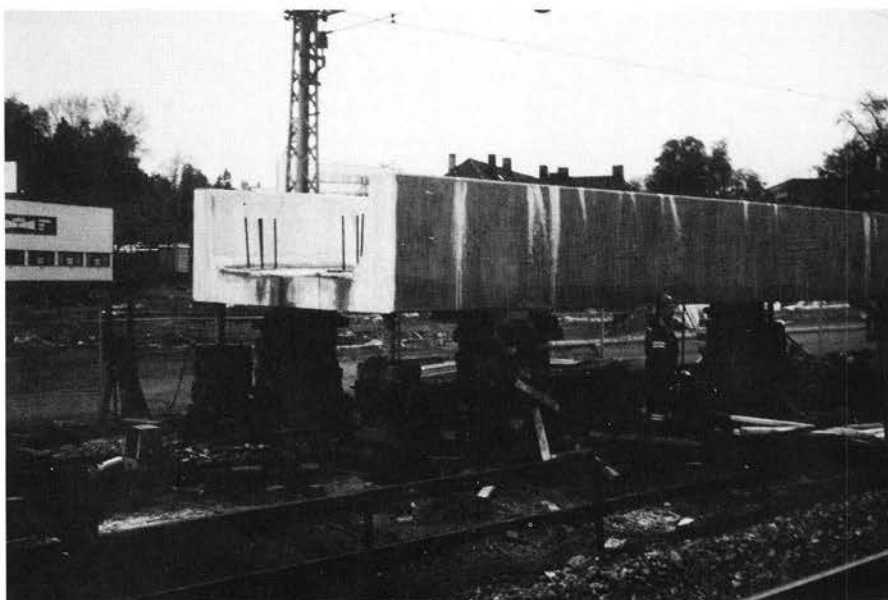
Undergang for Vennersborgveien, støpt og mellomlagret på Lysaker st.
