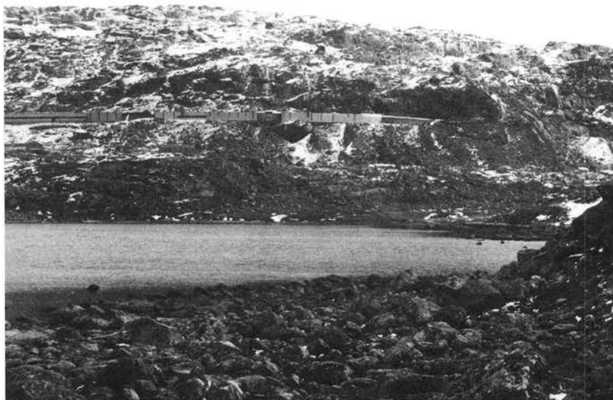
Tunnelens vestre påhugg befinner seg midt på bildet (alt. 1). Linja går i fylling over vannet og ligger i terreng høyde i det punkt bildet er tatt fra (km 313,8). (Foto: Ove Skovdahl)
