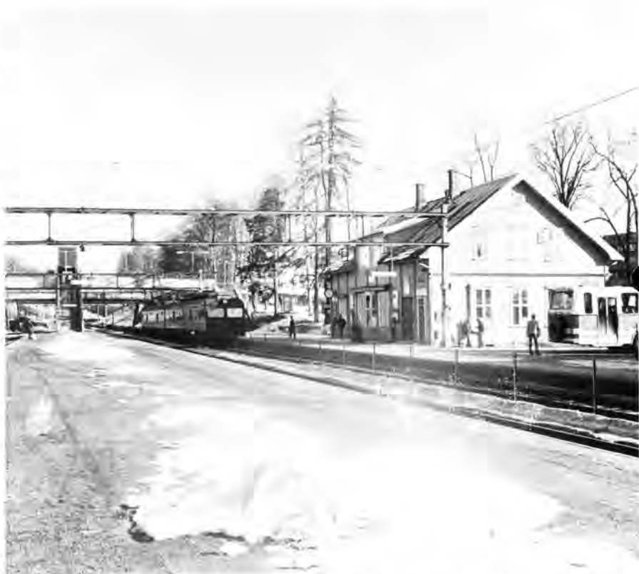
Ski stasjon har et plattformarrangement som tilsvarer «holdeplass C» med en sideplattform og en mellomplattform. Sideplattformen har direkte adkomst fra gatene, og det er lett å omstigne mellom tog og buss. Mellomplattformen har adkomst over en fotgjengerbro med trapp og heis til plattformen.
