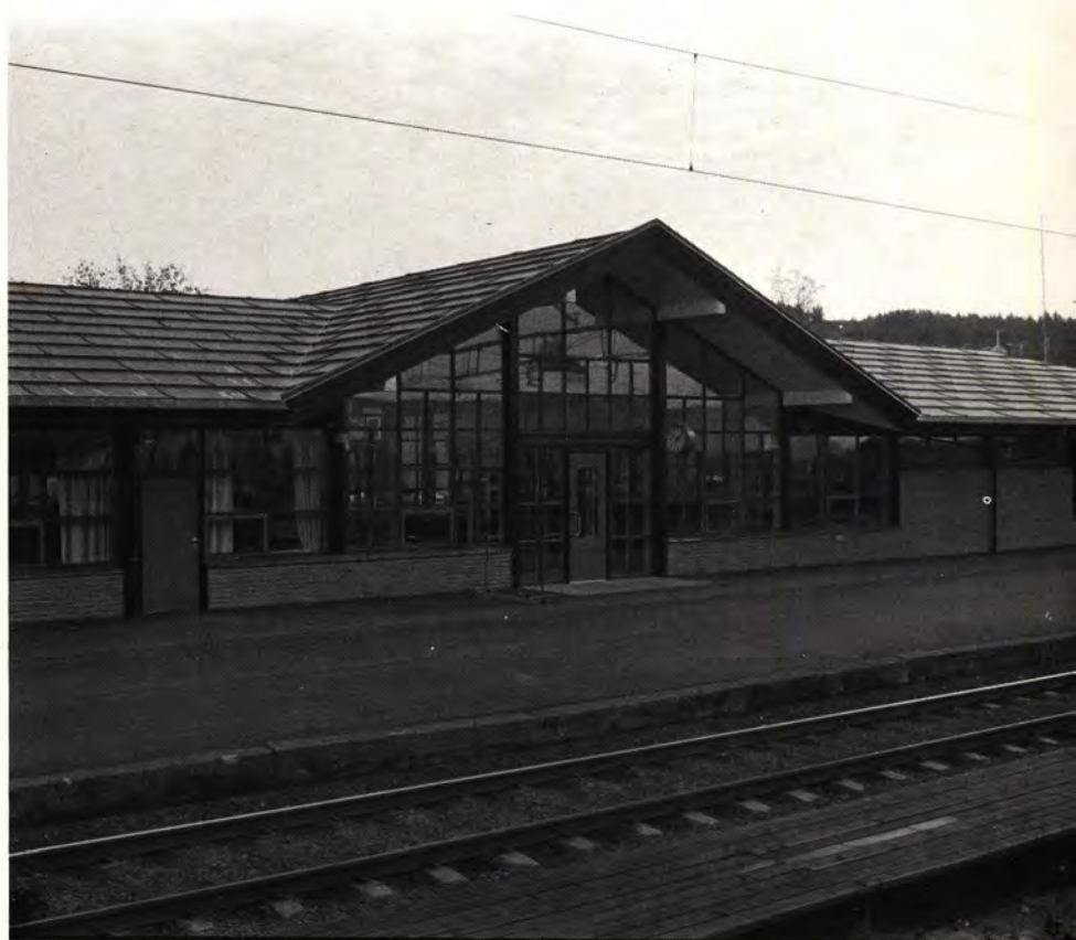
Den nye stasjonsbygningen i Moelv.
