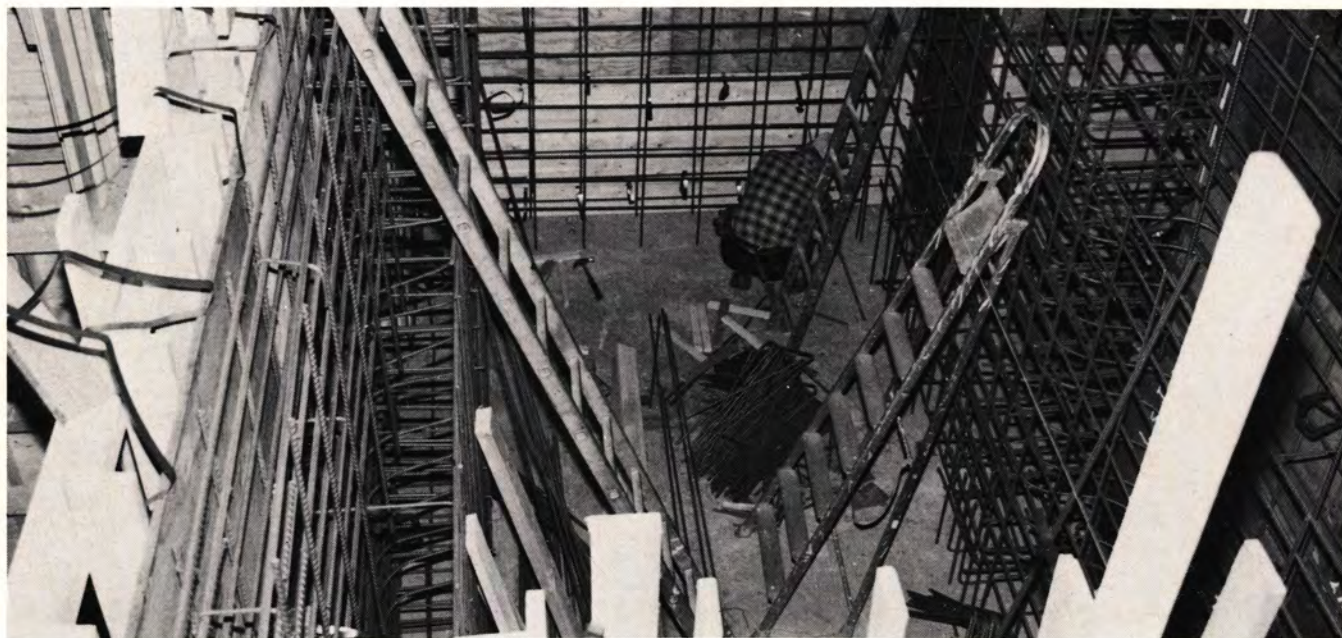
Fig. 3 øverst. Verkstedet Groruds hjulverksted med flytlinjer for vognhjulsetter inntegnet. Den øvrige del av hjulverkstedet ligger i lokomotivverkstedet og er ikke tatt med her Fig. 4 under. Fundamentet. Arbeide med armeringsjern i spongrava.
