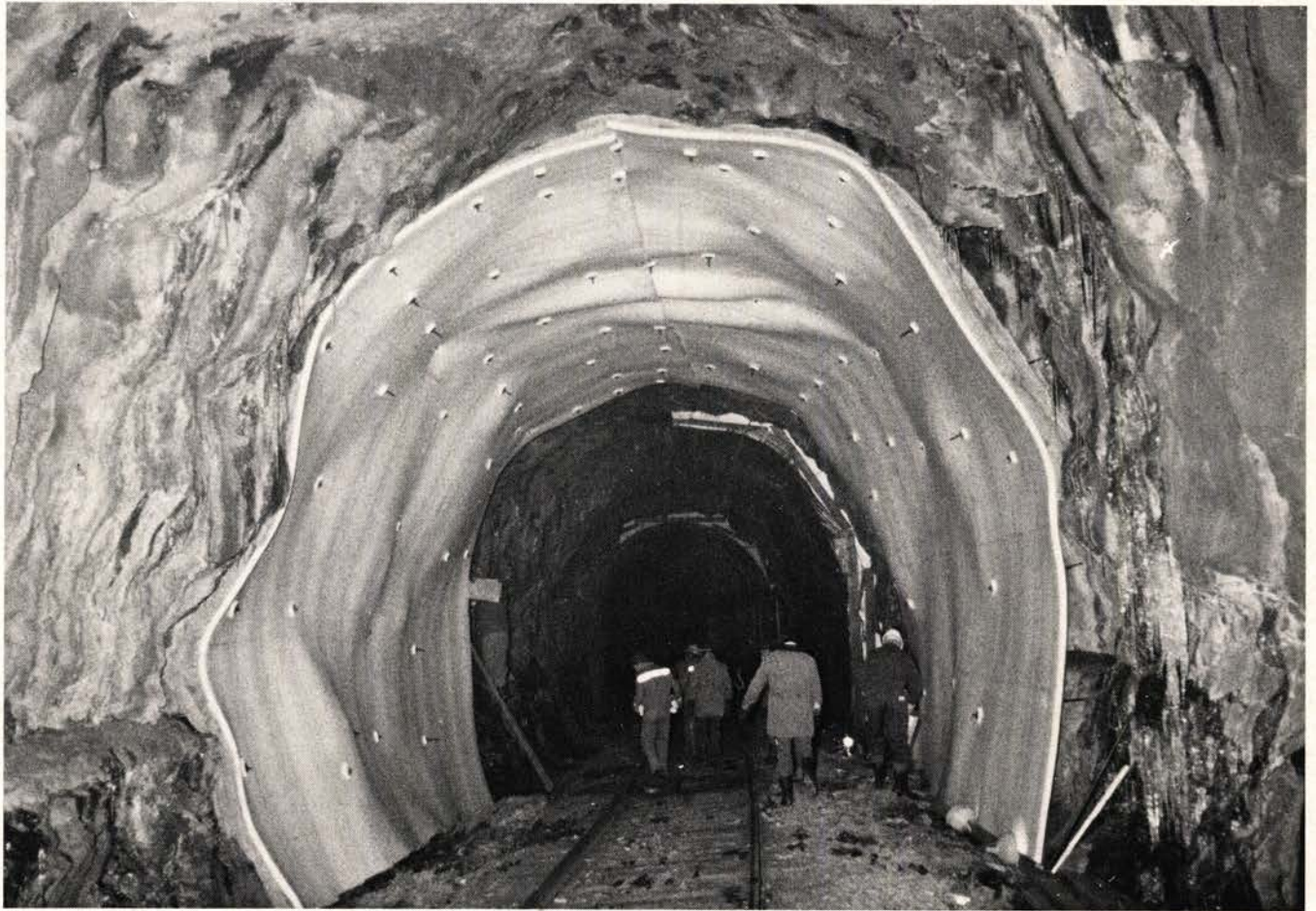
Fig. 4. 2 flak som hvert består av 45 enkeltplater isolerer 9 m av tunnelen.
