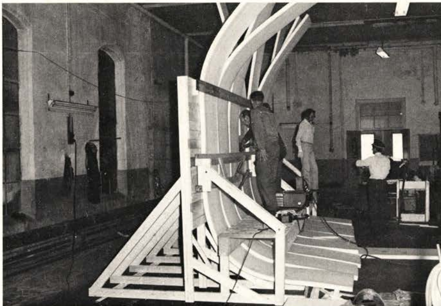
Fig. 1. Platene spennes fast i en jigg under limingen.
