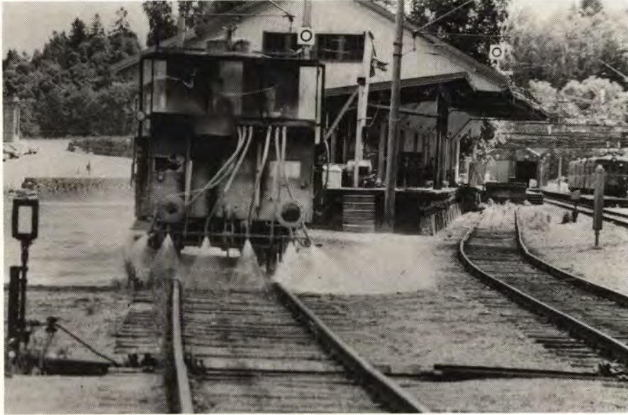
Fig. 1. Sprøyting med sprøytevogn. Vegetasjonskontrollen omfatter bl.a. utrydding av uønsket vegetasjon på stasjonsområder.
