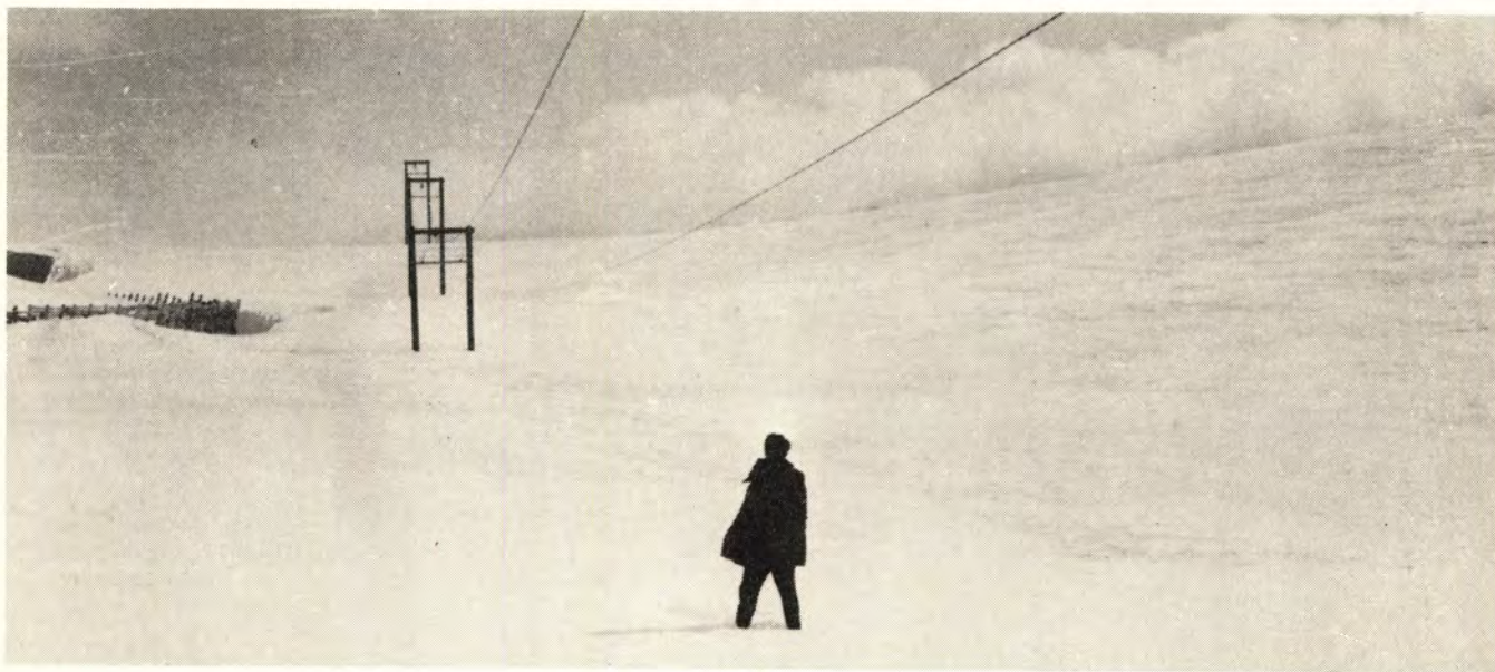
Fig. 8. Forsterkningsledningen hvor mer enn halve masten er under snøen.
