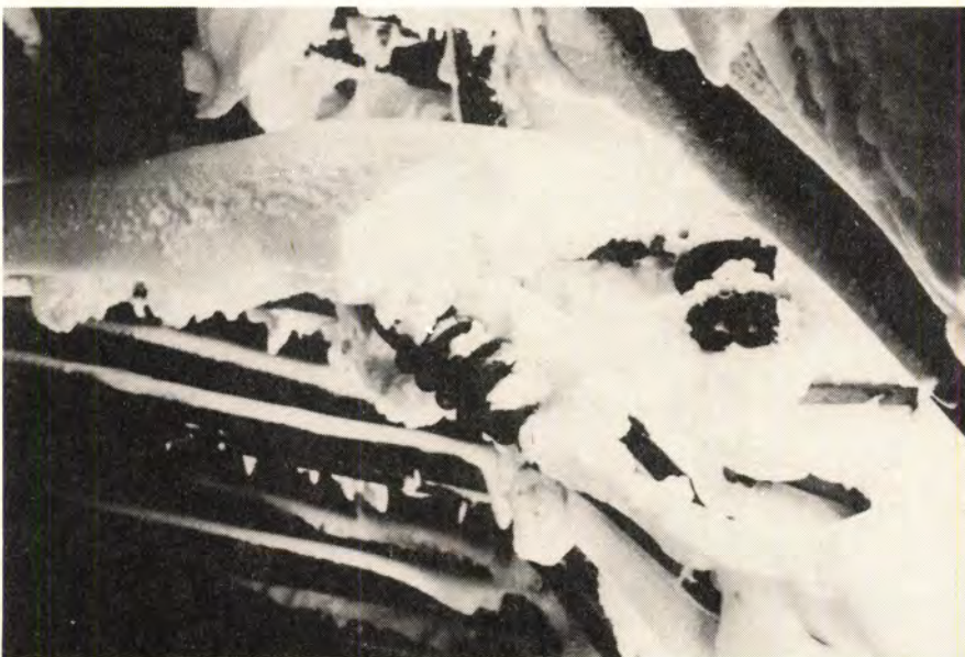
Fig. 6. En utligger kan såvidt anes inne i snøen inne i et snøoverbygg.
