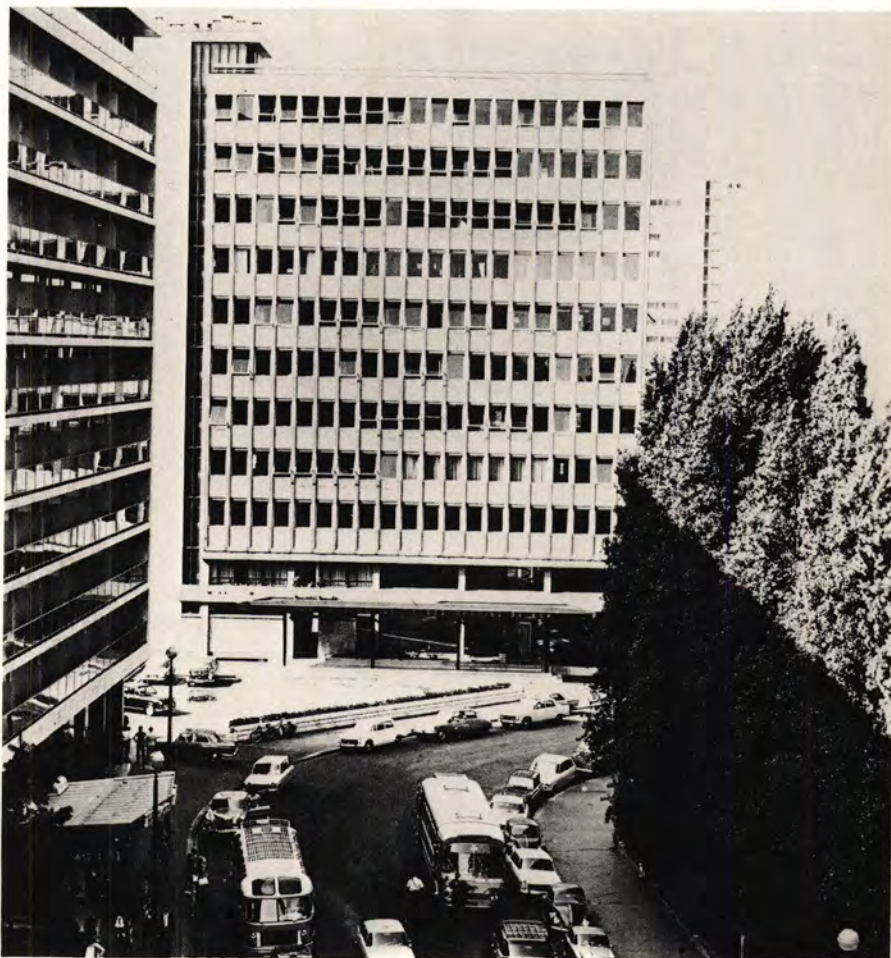
UIC's administrasjonsbygning i Paris.
