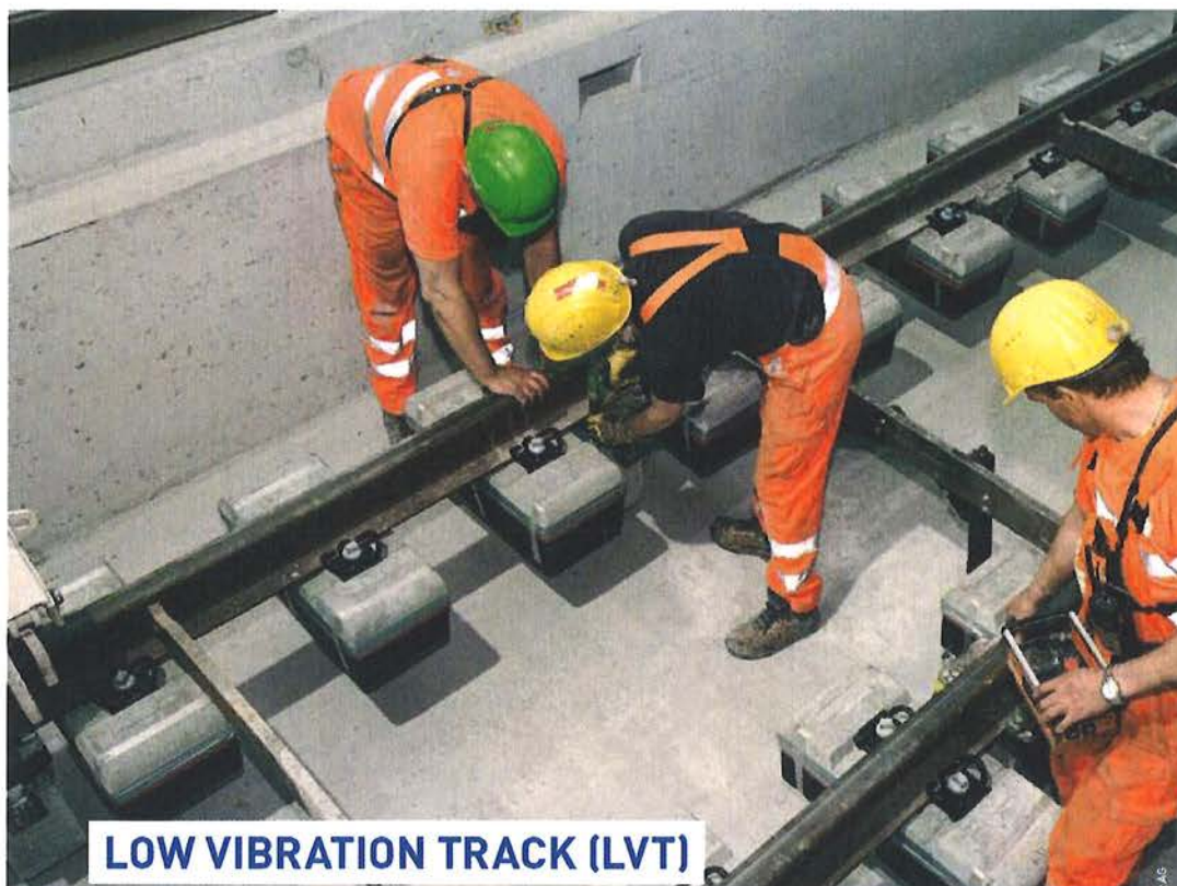
Bilde 1. Montering av LVT fastspor. Bilde fra Sonneville AG (Sveits)
