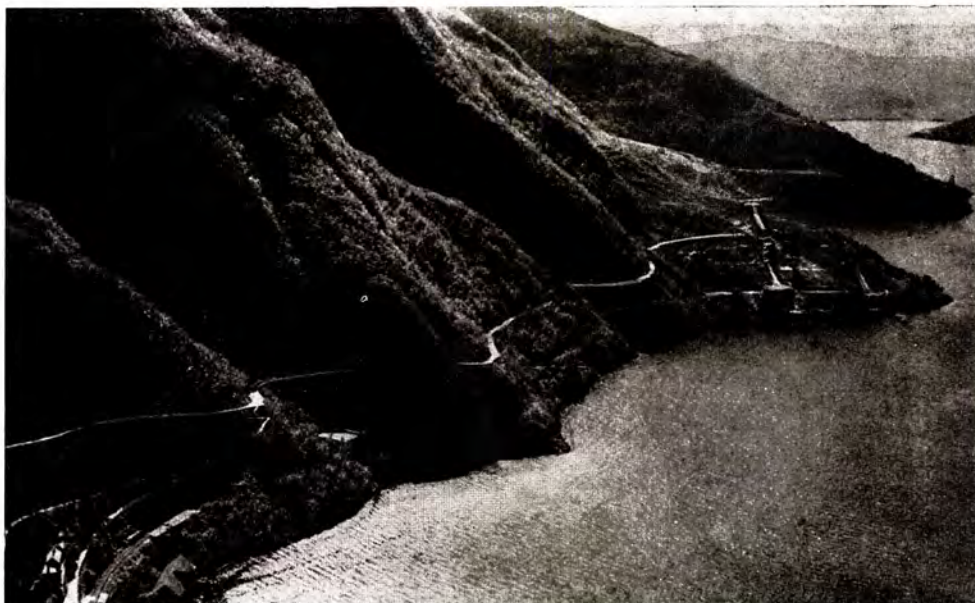
Fig. 5. Langs Sørfjorden. Bilvegen øverst, Bergensbanen nedenfor.
