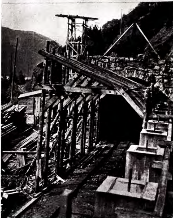
Fig. 5. Skredforbygningen under arbeid. Øverst: Vestre portal av Fosmark tunnel. Nederst: Stillas for den nye skredforbygning under arbeid.
