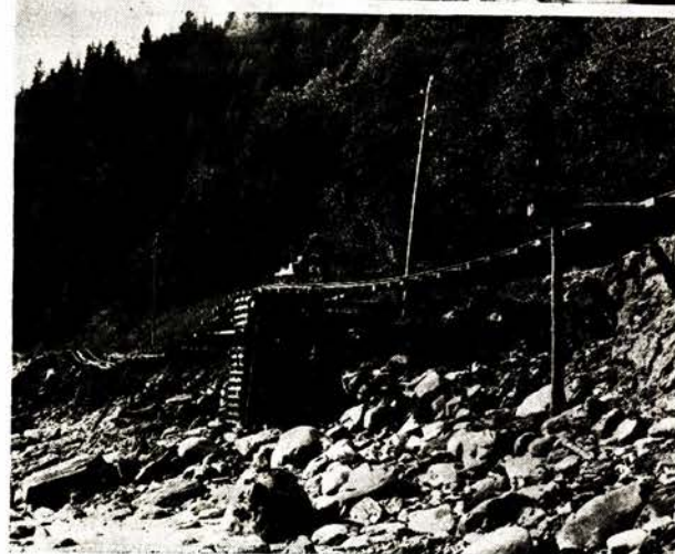
Fig. 6. Øverst. Nord for Bjørgen stasjon. Hele jernbanefyllingen er tatt. Nederst: Sør for Godøya mellom Rognes og Kotsøy. Skinnegangen henger i luften på lange strekninger, midlertidig opskolet.
