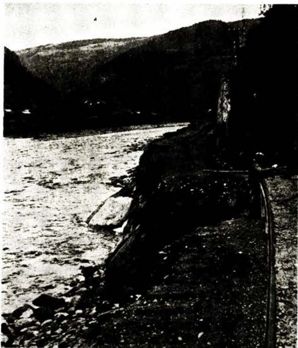
Fig. 4. Rognes stasjon. Stasjonsfyllingen med bygninger, vei og spor er feid vekk. Litt av gjenstående godsrampe til høire.
