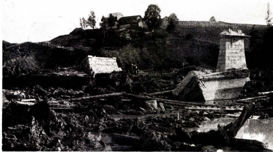
Fig. 3. Billedet er tatt fra ytre kant av raset øst for linjen og viser rasveggen, det utglidde landkar, sjetten pillars veltede fundament og den gjenstående pillar V.
