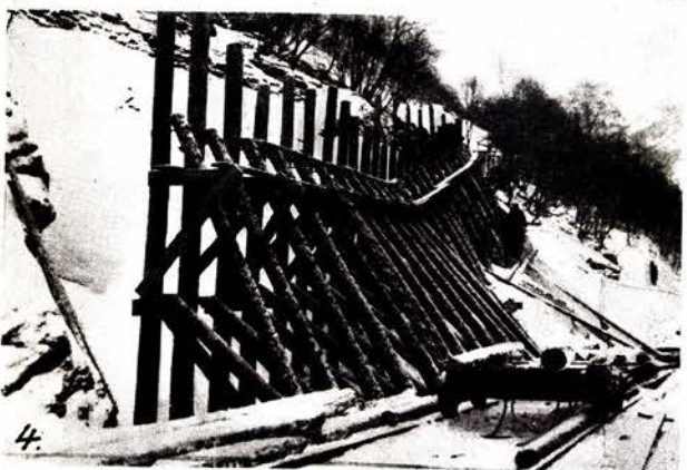
Fig. 1. Flåmsbanen. 3. Isparti ved Timberheller tunnel. 4. Påbegynt isskjerm ved Gjeithus.
