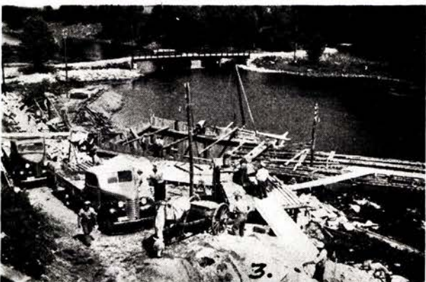
Fig. 5. Kristiansand—Moibanen. 1. Bru over Audnedalselven, buestillasje. 2. Bru over Audnedalselven, spuntvegg. 3. Bru over Audnedalselven, venstre fundament.
