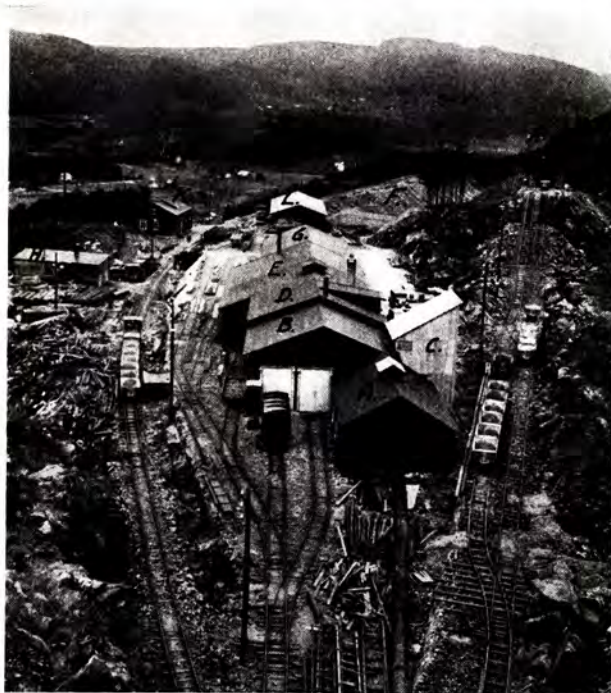
Fig. 2. Maskinboringsanlegg ved Vernesbeitunnel vestre innslag: A. Hus for ventilatorene. B. Lokomotivstall. C. Transformatoriosk. D. Kompressorhus. E. Verksted og smie. F. Fylling. G. Lagerhus. H. Hvilebod. K. Bad og kontor. L. Skur for trematerialer og ved. P. Pukkverk.
