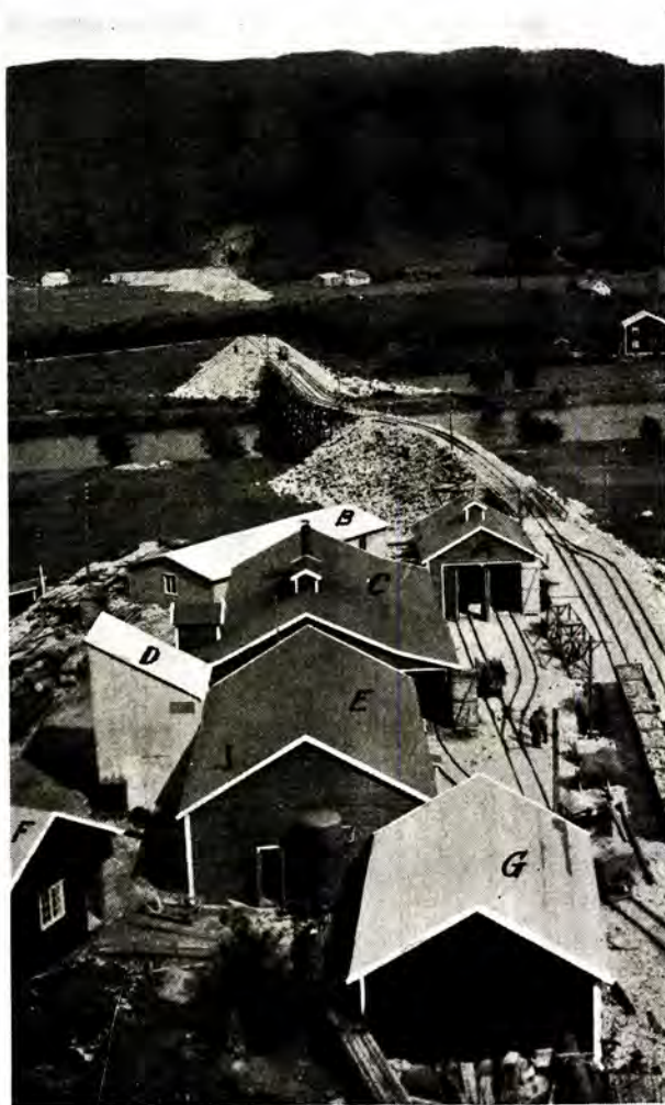
Fig. 1. Maskinboringsanlegg ved Kvineshei tunnel østre innslag: A. Lokomotivstall. B. Lagerhus og kontor. C. Verksted og maskinsmie. D. Transformatoriosk. E. Kompressorer. F. Bad. G. Ventilator. I bakgrunnen sees vestre innslag for Hegebostad tunnel (8455 m). Mellom elven og denne sees utfylling for Snartemo stasjon.
