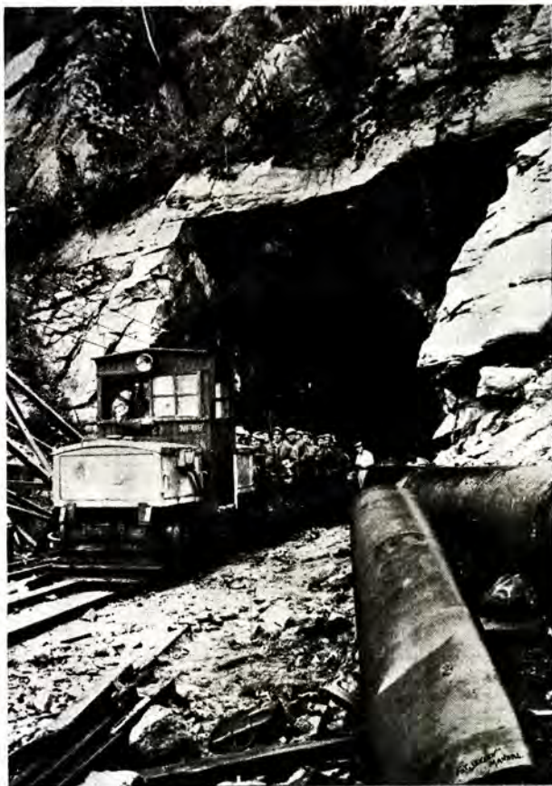
Fig. 11. Kvinesheitunnel øst. Arbeidslaget kjøres ut.
