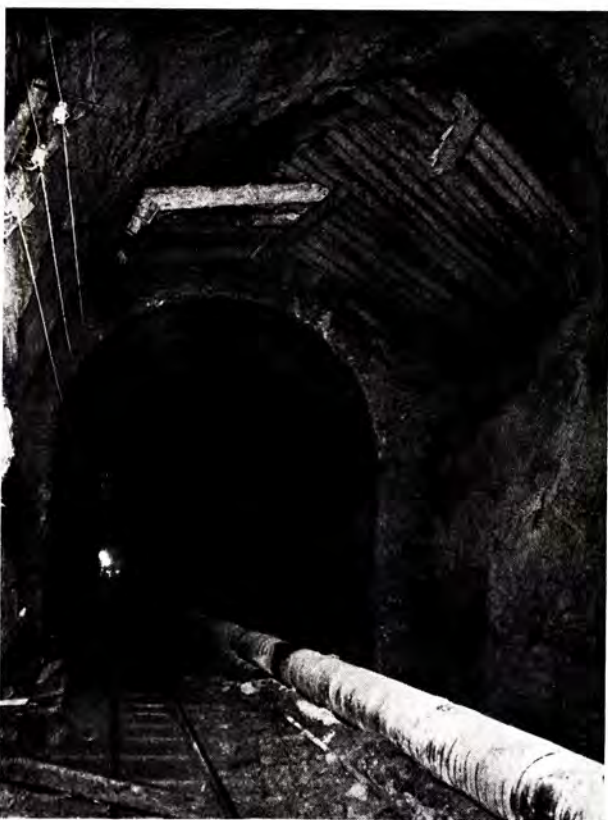
Fig. 3. Kvinesheitunnelen vest. Stemplet parti og utstøpt tunnel. Ventilasjonsledning tilhøre.
