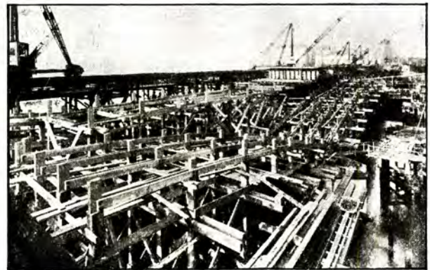
Bærende trestillaser med „ALLIGATOR” ved større brobygging i England.
