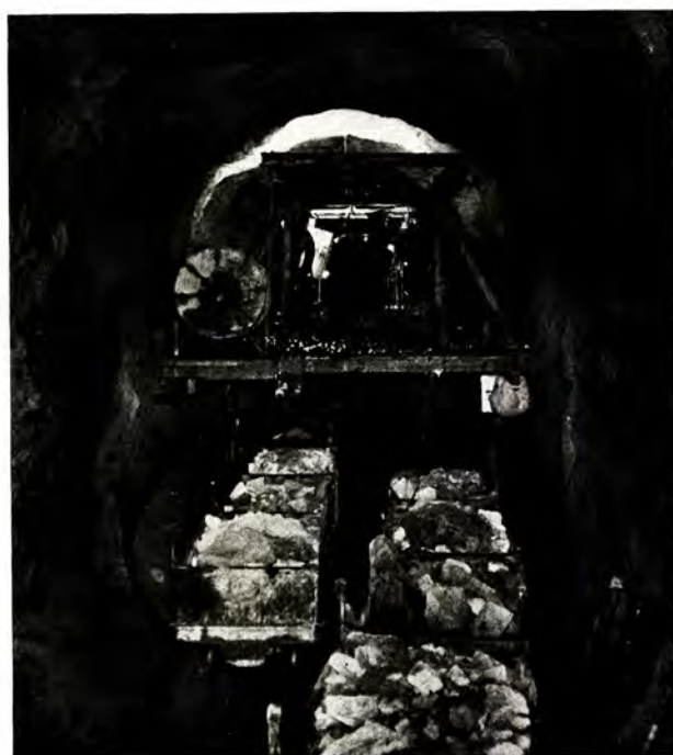
Fig. 8. Kvinesheitunnel vest. Tunnelbukken sett bakfra med lastede vagger under.
