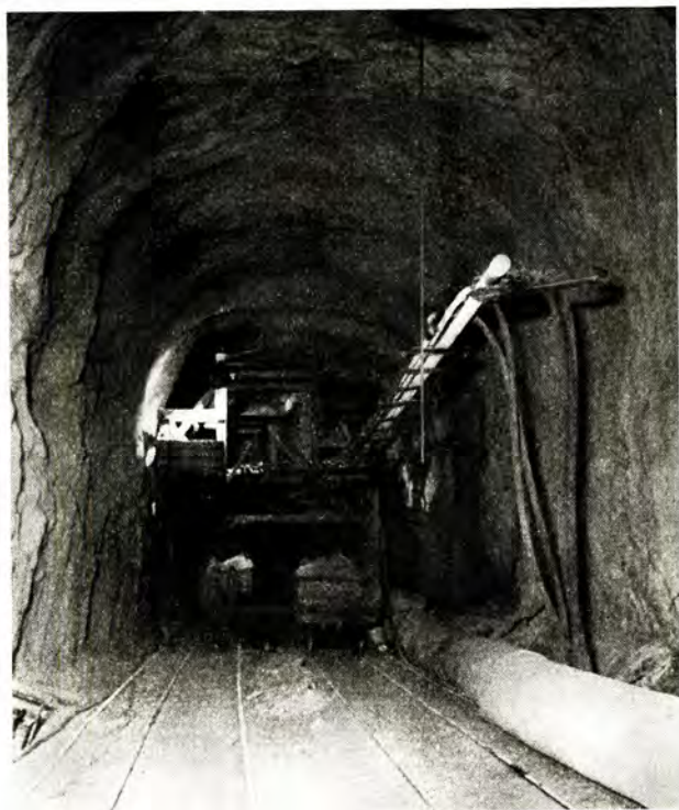
Fig. 6. Kvinhei-bukken (øst) sett bakfra med tilhengerens faste anordning for luft- og vannrøropphegning.
