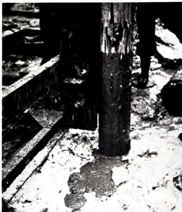
Fig. 2. Fotografi av en trepel som rammes i kvikkleire. Pelen har flytt opp ca. 1 m for bremseanordningen har virket. Omrørt flytende leire har tytt opp langs pelen og renner ut over horisontal mark.
