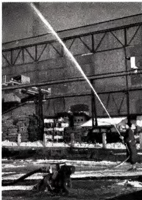
Pumpe med 2 1/2" slange, 3/4" strålerør. KLOAKKVANN
