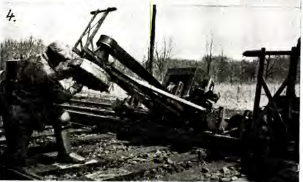
Fig. 2. Nordberg Spike Puller. Klypen som trekker ut skinnespikeren sees nederst på fig.
