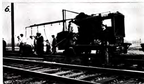
Fig. 5. Burro-kran. Skinnvekt 152 pd, skinnelengde 39 fot. Vekt av hele skinnen ca. 900 kg. Fig. 6. Transportabel kompressor med 4 pneumatiske hammere — og plass til 6 stk. — med lufttilførsel gjennom den lange utligger.
