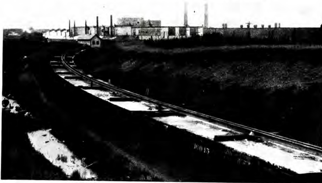
Fig. 3. Sveisede langskinner kjøres i kurve R = \text{ca. } 150 \text{ m.}
