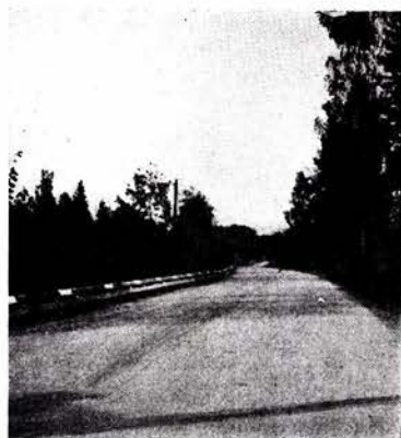
Prøvedekke med Stahlas (Kvartsit-Stahlas) lagt i 1936 på Ringeriksveien (Akershus)
