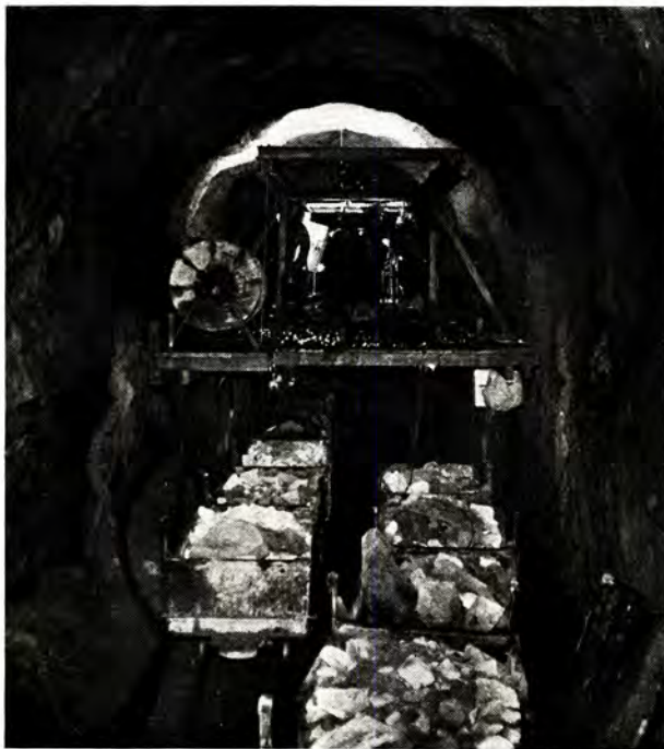
Fig. 5. Kvinesheitunnel vest. Tunnelbukken set bakfra med lastede vegger under.
