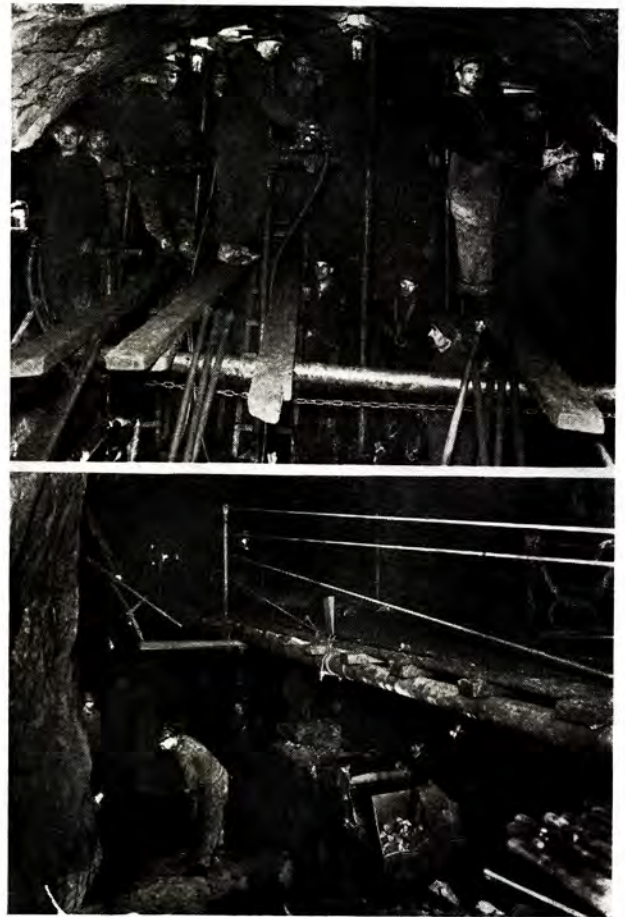
Fig. 6. Kvineshei tunnel vest. Øverst: Boring av galleri. Nederst: Lasting med Einco lastemaskin set fra stuff under utliggerbroen.
