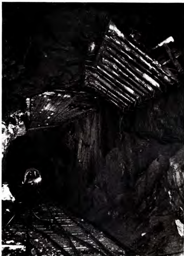
Fig. 7. Kvinesheittunnel vest. Stempling av råtagang, som senere skal utmures.
