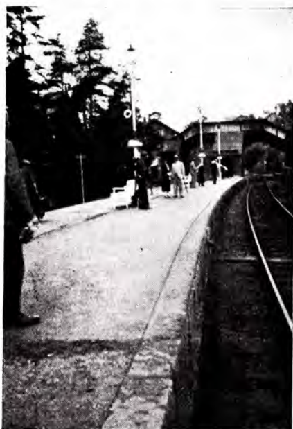
Icobetongdekke lagt på plattform på Nordstrand stasjon (1935)
