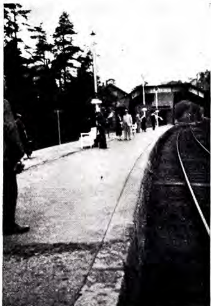
Icobetongdekke lagt på plattform på Nordstrand stasjon (1935)
