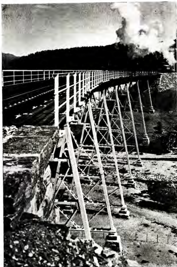
Moripen viadukt, 128 m lang.
