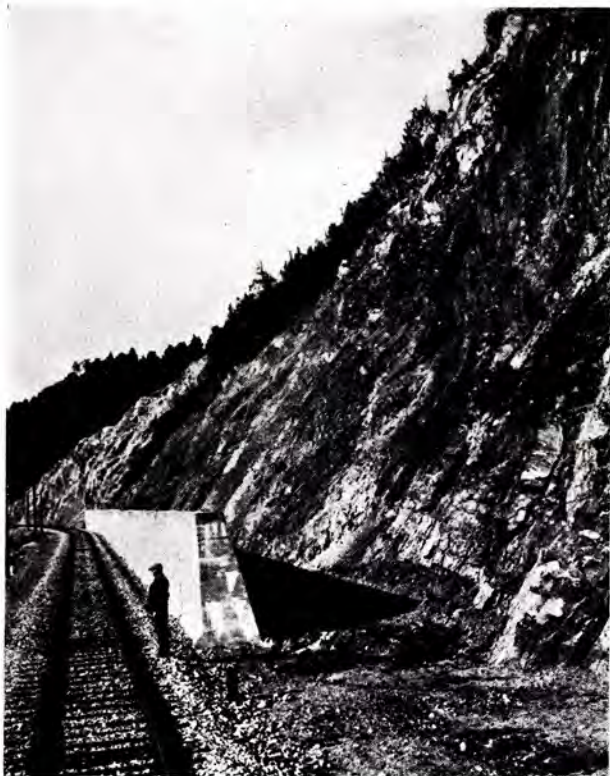
Fangmur mot steinras i Skjærkedalen.
