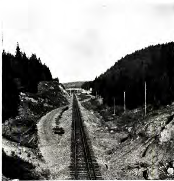
Ombyggingen Kristiansand—Grovane: Sørlandsbanen skjærer i en lengre rettløpe over en rekke skarpe kurver i den smalsporete Setesdalsbane mellom Grovane og Vikeland.
