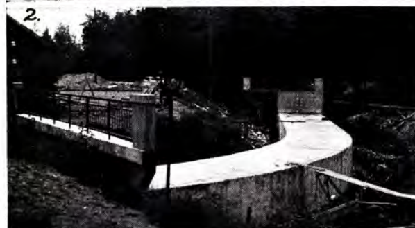
1. Nytt godshus på Kristiansand stasjon. 2. Kulvert for Natmannsbekken, Kristiansand st.
