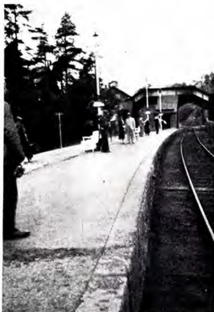
Icobetongdekke lagt på plattform på Nordstrand stasjon (1935)
