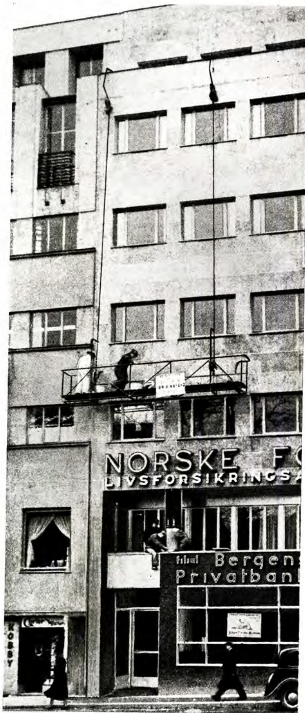
2 app. nr. 2 anvendt ved installasjonsarbeide på „Norske Forenedes Hus“, Oslo.
