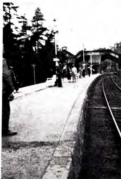
Icobetongdekke lagt på plattform på Nordstrand stasjon (1935)
