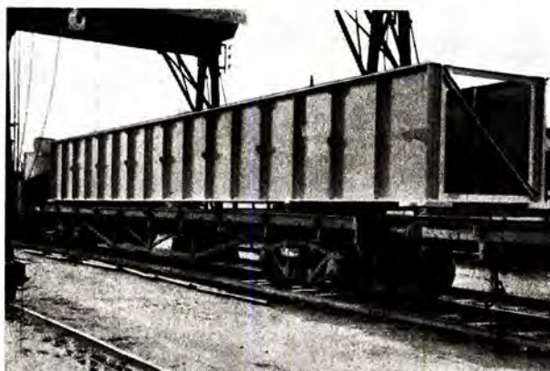
Fig. 9. Ferdig platespenn, oplastet på jernbanevogn for transport til brostedet.
