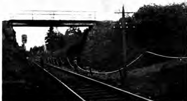
Kabelutlegning om natten.
