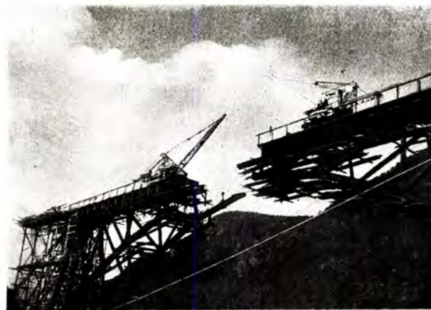
Fig. 22. Utsetning av undergurt.
