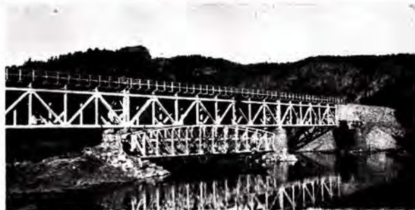
Øverst: Lokomotivstall (t. h.) og verksted (t. v.) på Krossen stasjon ved Kristiansand S. Nederst: Ny bro over Otra. Største og siste spenn i gammel bro nedsenket på leker for demontering.
