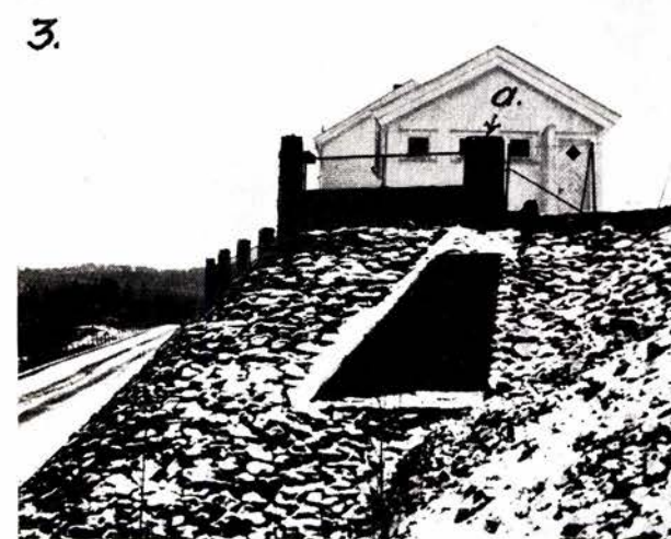
Fig. 2. Innkast av søppel gjennom side-dør av jern i hulrekkeverkspilar «a» til kum i fyllingen. Fig. 3. Sjakt til søppelkum i fylling.
